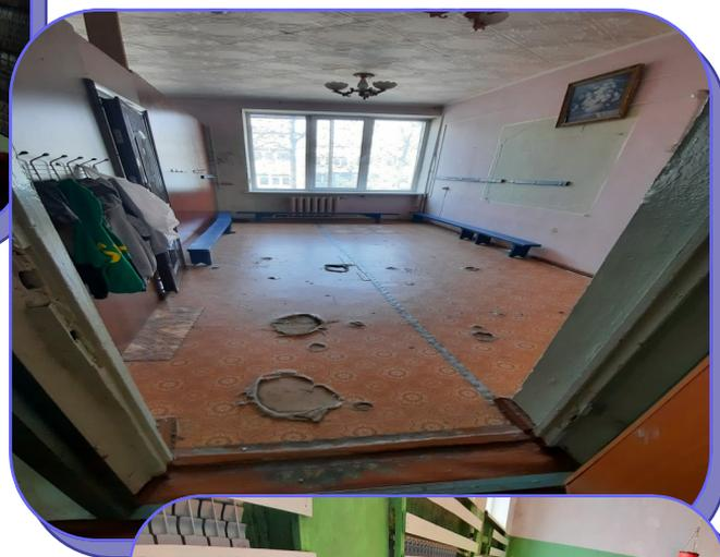
Имеются протечки крыши. Имеется отслоение штукатурки от стен. Сан узел полностью в нерабочем состоянии. Защитные конструкции системы отопления (радиаторов) имеют повреждения в виде сломанных деревянных реек. Напольное покрытие в раздевалках имеет разрывы, на стенах видны следы отслоения штукатурки, приборы освещения не соответствуют современным стандартам
